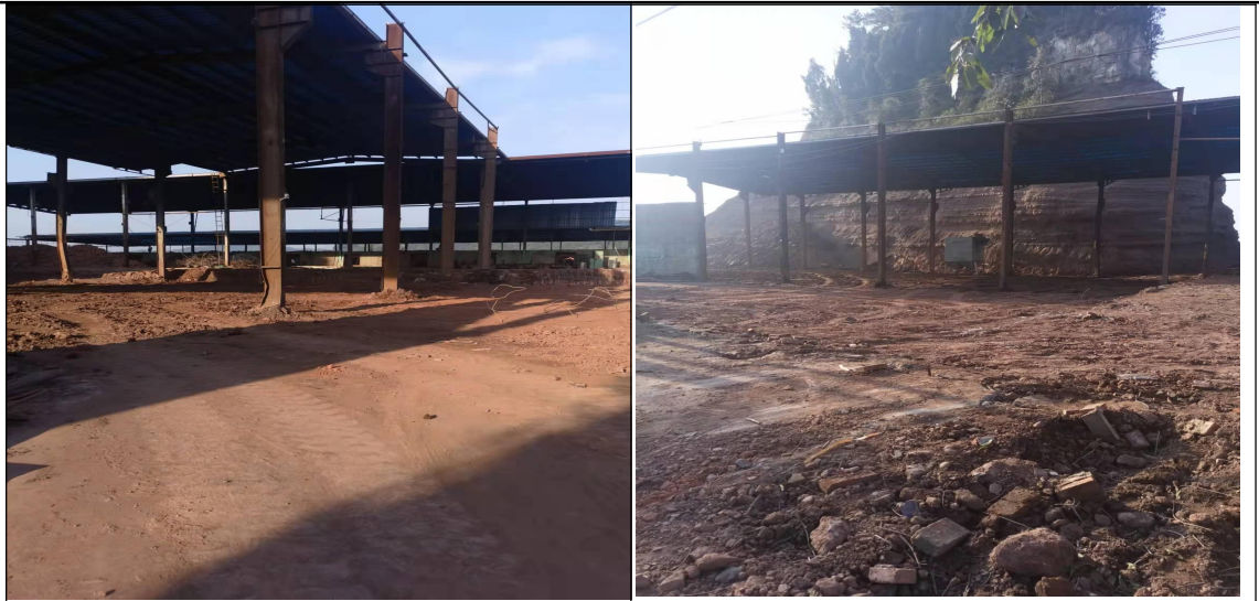
原有厂区拆除现状
