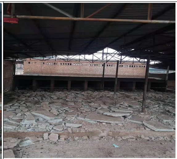
原有厂区拆除现状
