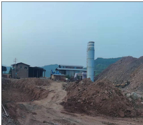
原有厂区拆除现状
