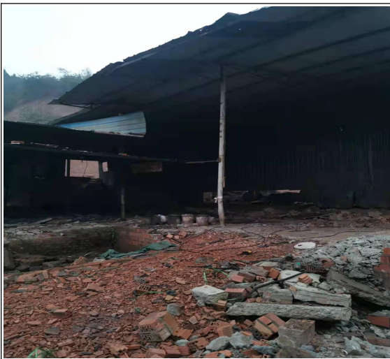
原有厂区拆除现状
