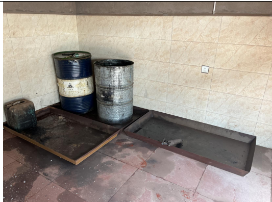
图 5 原有项目危废暂存间
